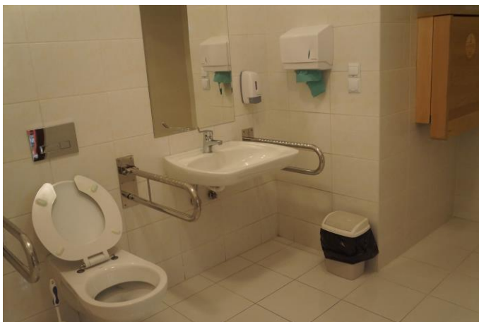
Toilet for PRM on Railway Station (Dworzec Zachodni w Warszawie)
